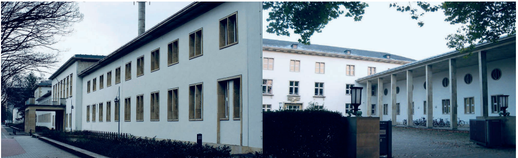
Bild 22 Ehem. Luftgaukommando in Münster, Stabsgebäude Lufttransportkommando, Manfred von Richthofenstraße, Münster
